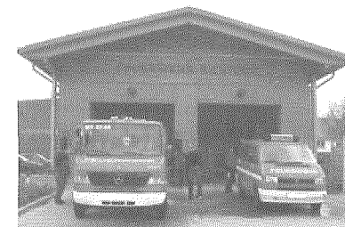
Neue Feuerwehr und Turnhalle in Silstedt
